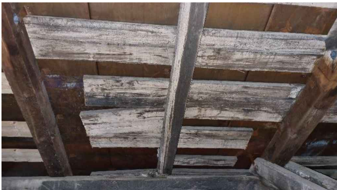
11.fotoattēls Lokāli izzāgēts jumta seguma dēļu klājs.
