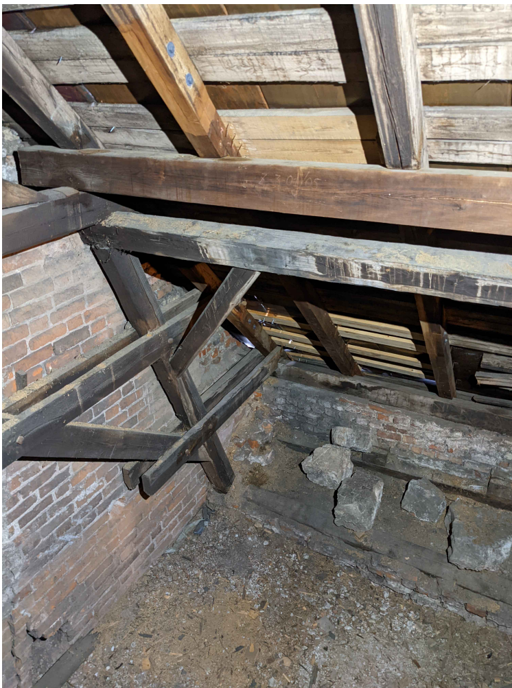
6.fotoattēls Sekundāri latojuma labojumi un spāru protezējumi.
