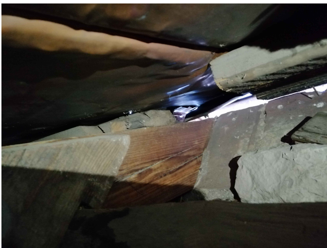
12.fotoattēls Spāru galu balstvieta virs mūra dzegas.
